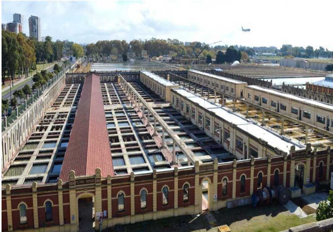
Vista de la Planta de Tratamiento de Agua Potable San Martín.
