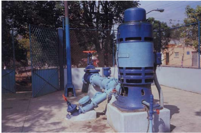
Fotografía No.7: Pozo con brocal y protección adecuada
