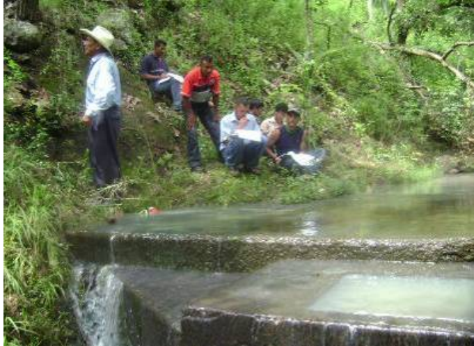
Fotografía No.1: Recorrido por la Captación
