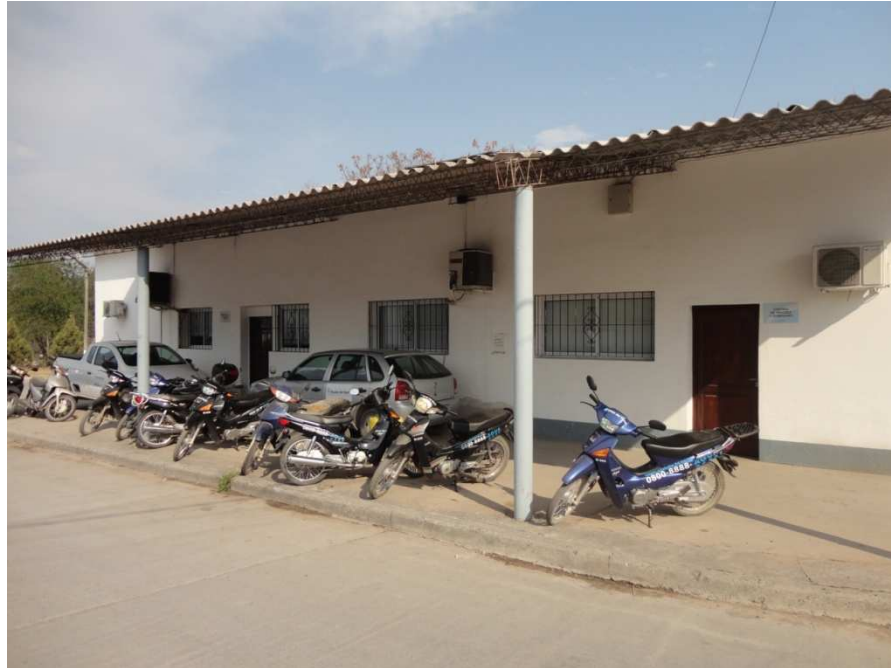
Unidade de Alta Molina – Sede do Departamento Operacional
