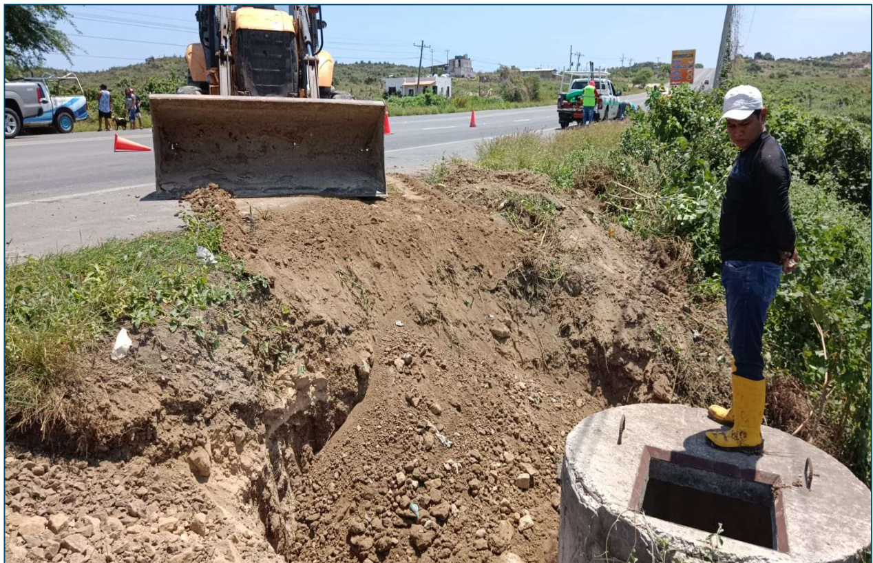
Acciones de retiro de tomas ilegales para zonas sin redes de distribución.
