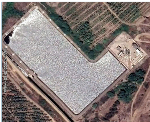
Captación del canal “Río Verde” Km 16.2
