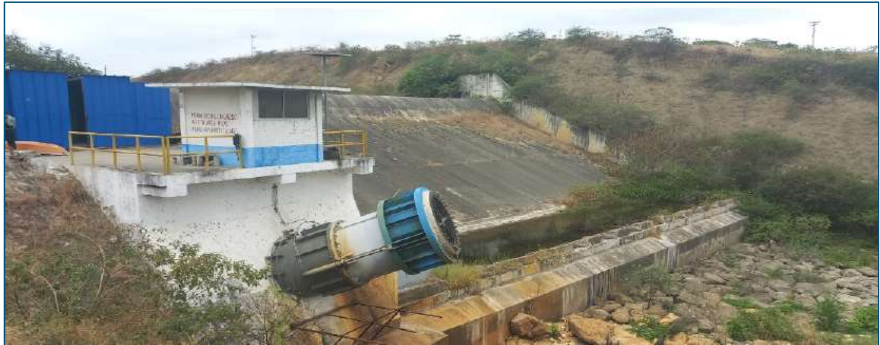
Aliviadero y válvula de desfogue del reservorio “El Azúcar”
