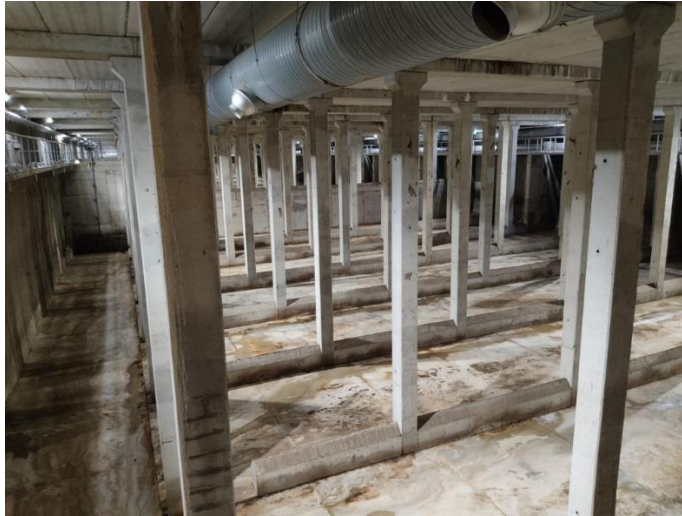
Foto 2. Compartimiento 2 del depósito de retención
