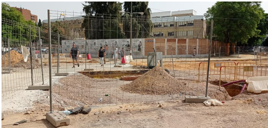
Foto 18. Enmallado para demarcar sitios de obra
