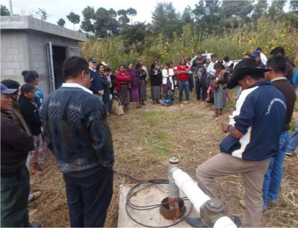
Visita a terreno Pozo Nueva Esperanza.
