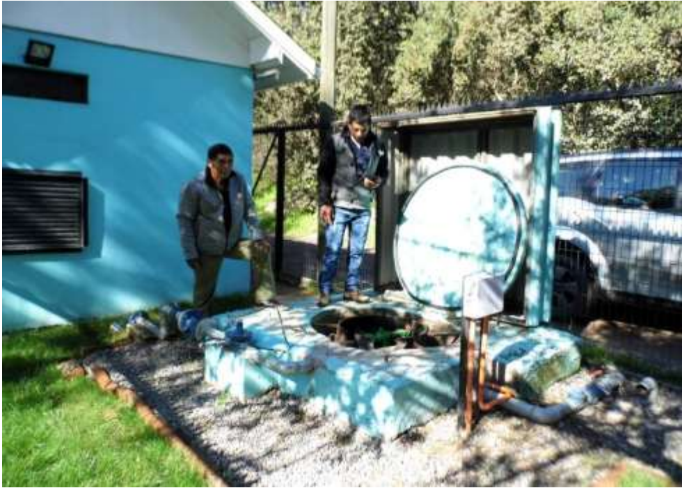
Instalación eficiente de equipo bomba en pozo.
