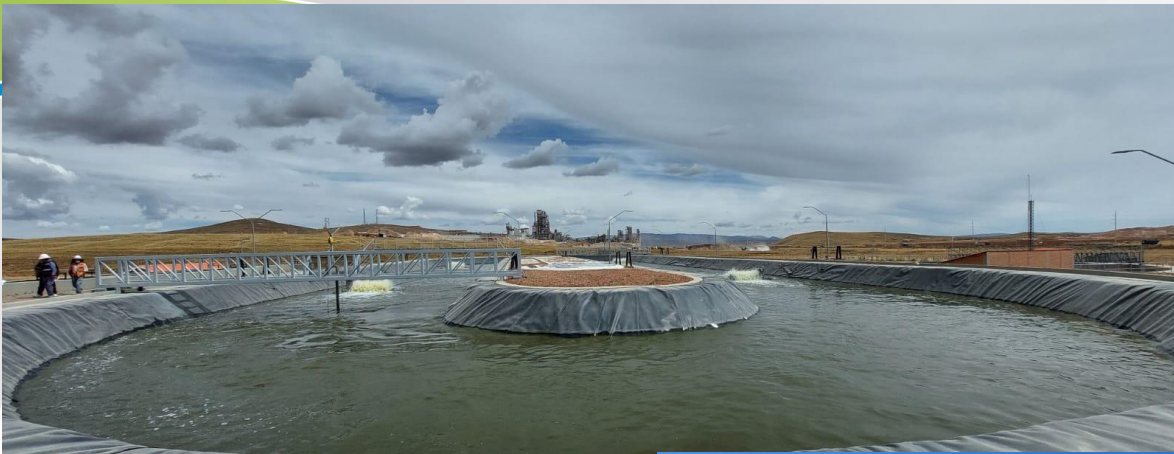
Zanja Oxidación PTAR Viacha abril 2021
